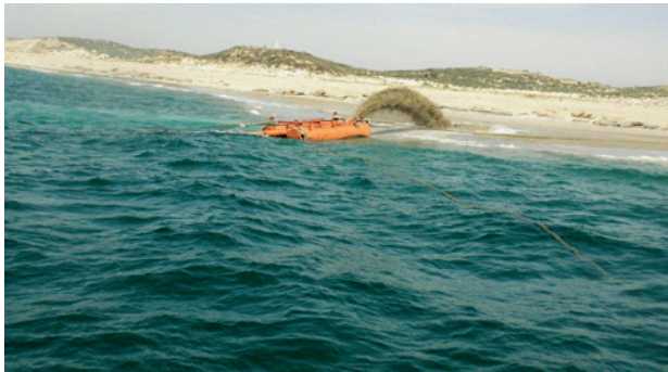
הזנת חוף מצפון לנמל אשדוד - ספינת מחפר מזרימה חול בצינור, והחול מותז לחוף. הבנייה לאורך החוף המפריעה להסעת החולות צפונה | צילום: גידי בשלהיים
